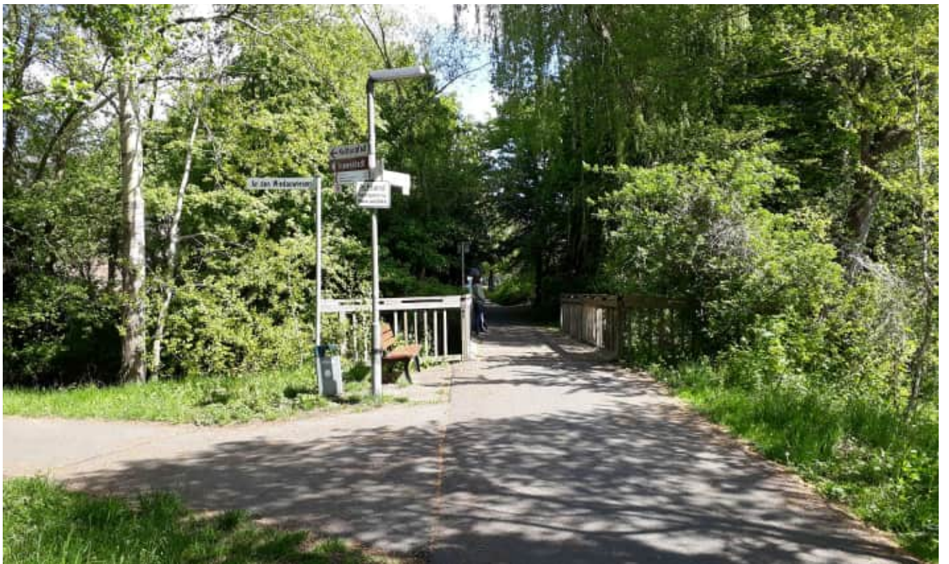
Abb. 61: Bachbrücke (Quelle: planwerkStadt)
